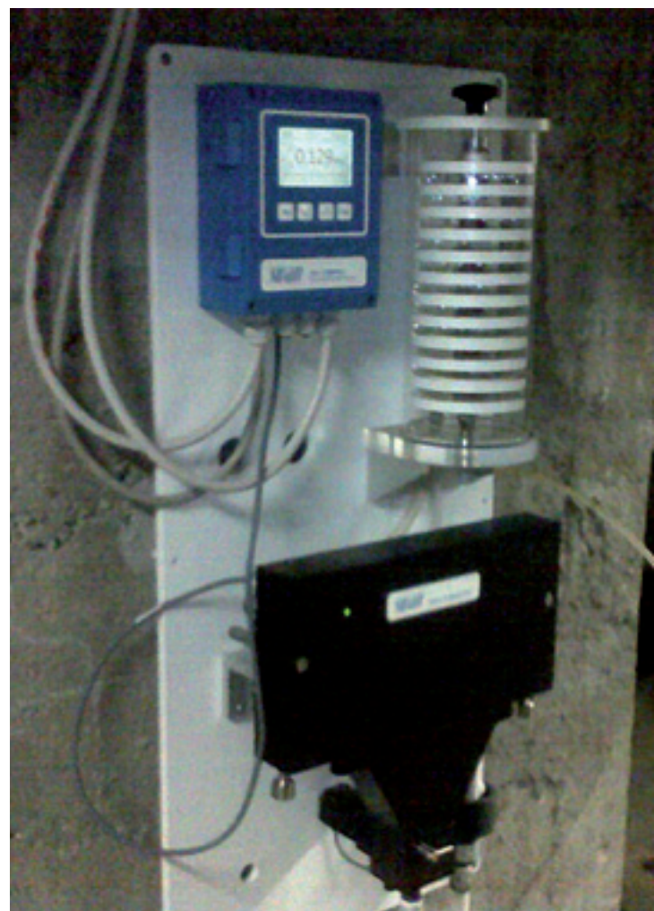
Monitor AMI Turbiwell sistema non a contatto per misure di torbidità
